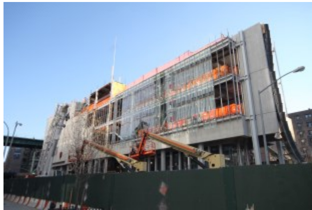
Instalación de la fachada de cristal en el lado norte del Forum
