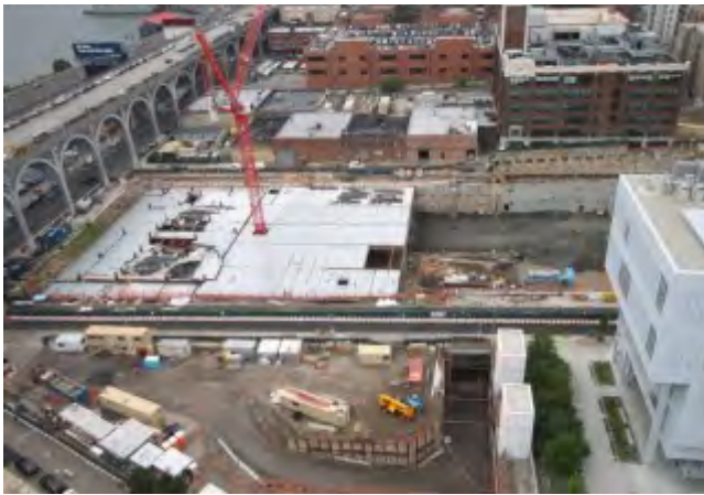
Las bases de la Fase 2, mirando hacia el norte
