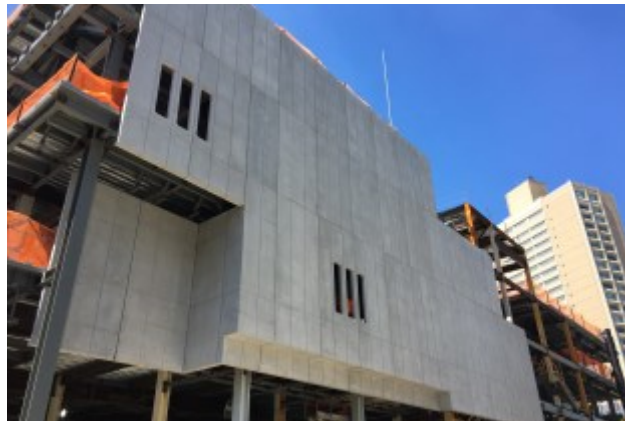
El lugar del edificio Foro, mirando hacia suroeste
